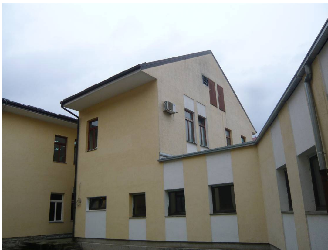
- ISTOČNO DVORIŠNO PROČELJE -
